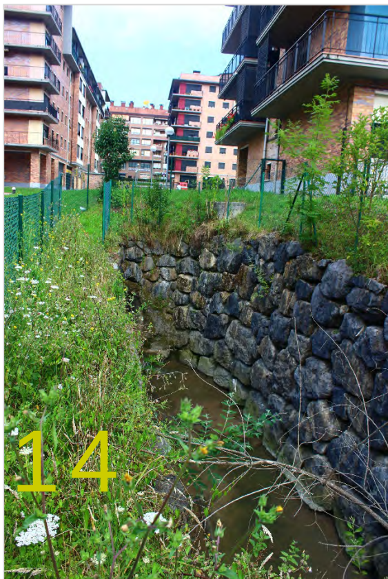
14. argazkia. Etxeberriko sektorean (Urnietako iparraldeko hiri-fatxada), berriz ere Trankatx ibaia agertzen da, hodi handi batetik eta harri-lubeta oso txundigarrietatik abiatuta, lurkara ezpondari nahiz fluxu hidrikoei eusteko diseinatutakoa, batez ere uholde handiak eta prezipitazio handiak gertatzen direnerako. Uraren kalitateak nabarmen egin du behera herrigunetik igarotzearen ondorioz.
