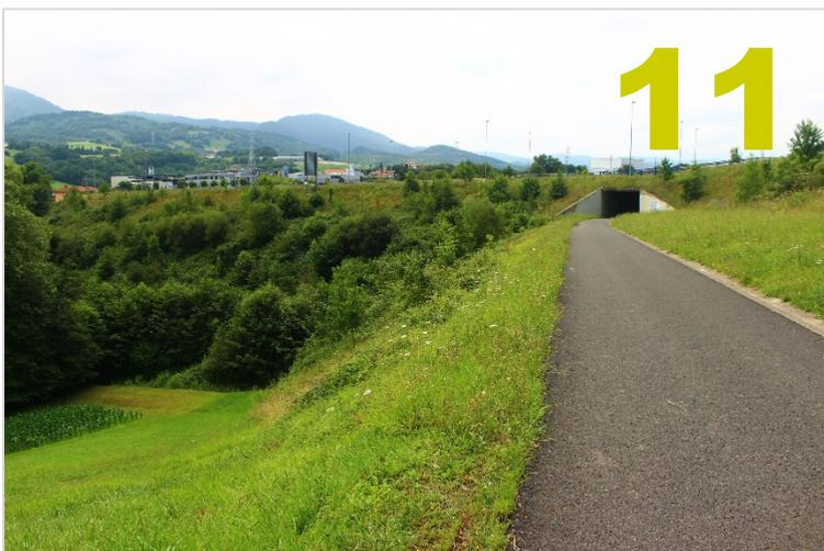
**Fotografía 11.** Obsérvese la dificultad de conectividad hídrica derivada de la pasante del ramal hacia la Autovía. Por su parte, la vía verde del Plazaola solventa dicha cuestión a través de un túnel. El trazado de este camino peatonal y ciclable tiene un buen firme y anchura. Aunque es bastante utilizado tiene importantes problemas de conectividad y seguridad para su uso.
