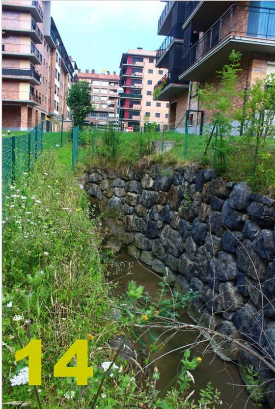
**Fotografía 14.** En el sector de Etxeberri (fachada urbana septentrional de Urnieta) vuelve a aparecer el río Trankax a partir de un gran tubo y unas escolleras muy impactantes diseñadas para aguantar tanto el talud terroso como los flujos hídricos, especialmente en momentos de grandes avenidas y fuertes precipitaciones. La calidad del agua ha descendido considerablemente como consecuencia de su paso por el casco urbano.
